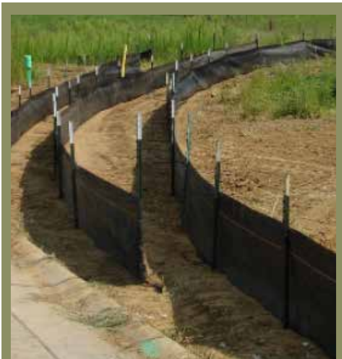
Figuur 3: Slikheinings kan van skadunet, pale en draad gebou word om water stadig deur te laat.
